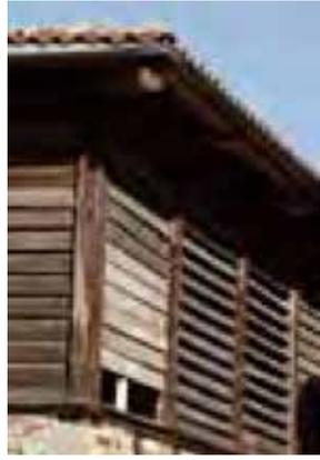
Un mécanisme permet de régler finement l'inclinaison des lames au moment de leur mise en œuvre afin de réguler l'intensité du filtre.
